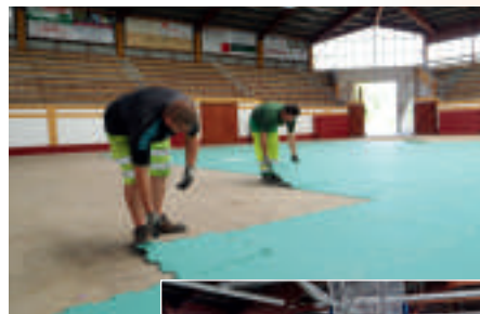
Les 2 étapes de la pose du sol
